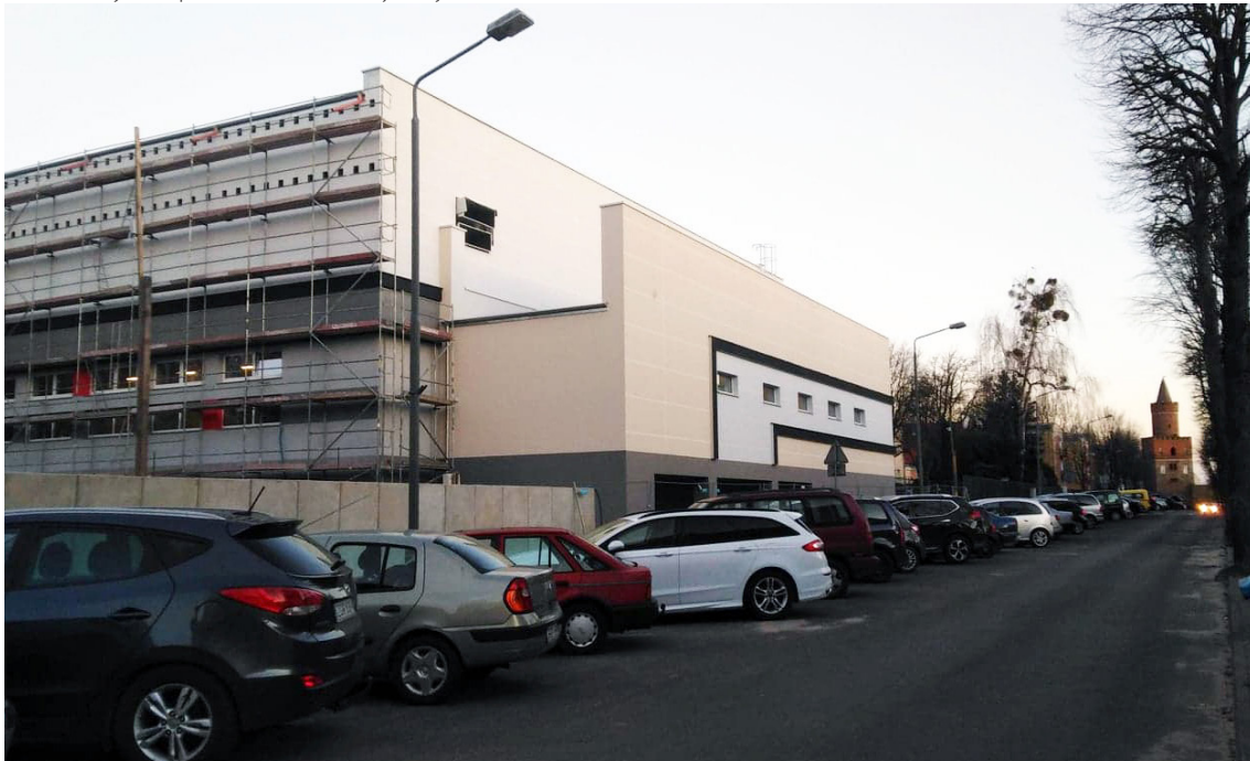
Stan budowy hali sportowo-widowiskowej w Gryfinie
