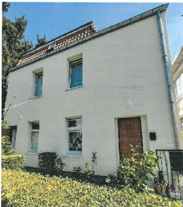
Remont elewacji budynku przy ul. Łużyckiej 10
