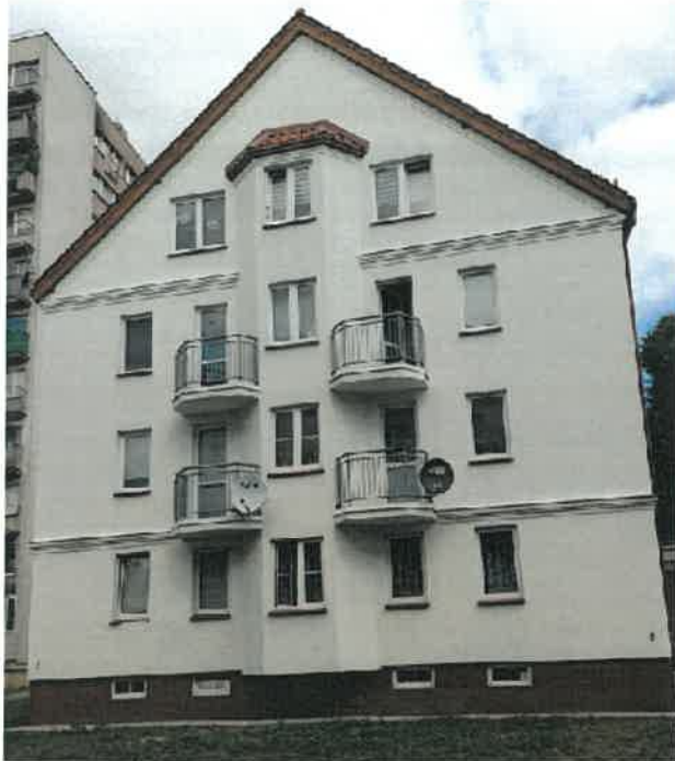
Remont elewacji budynku przy ul. 1 Maja 11
